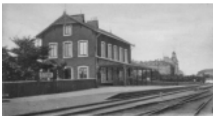
Östervärns station med Solstrålehuset i bakgrunden. Foto: Malmö Museer.
